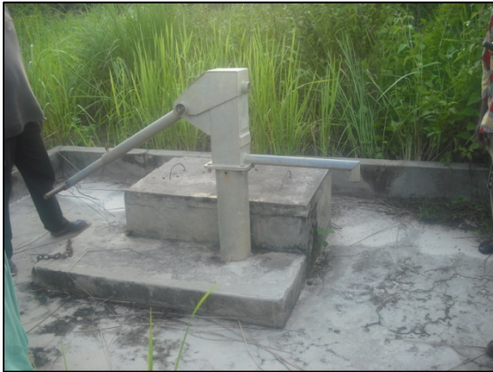
Photo 42. Borne fontaine dans le village d'Impouo (non fonctionnelle)
