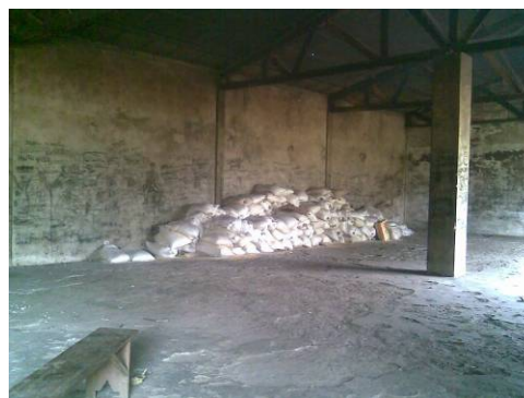
hangar étanche (toiture réhabilitée)
