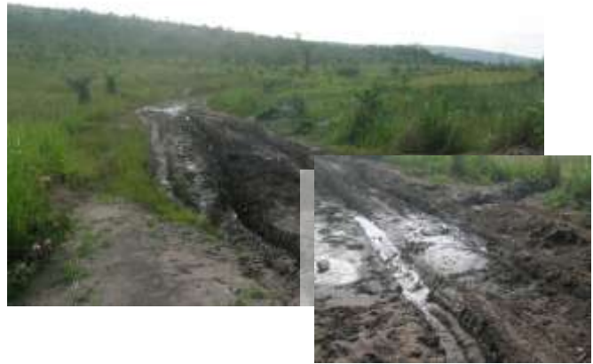
Photo 17 : Borbiers dans les sols hydromorphes de fonds de vallée (3) Confluent Nguidi-Djouari, près de Louheto. en sortant de la déviation précédente.
