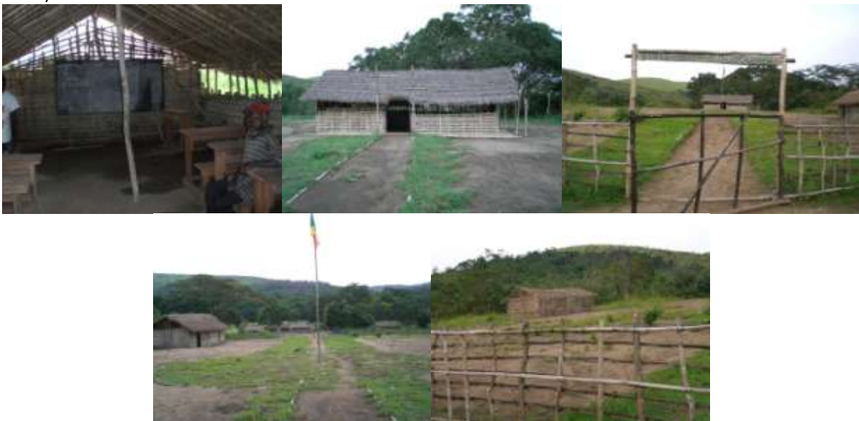
Photos 49 : Ecole de Kingandou Nguimbi. Dernière photo : case de passage en construction.
